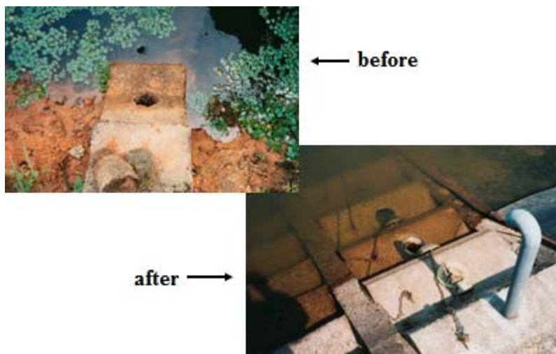
รูปที่ 8 การปรับปรุงอาคารระบายน้ำ
